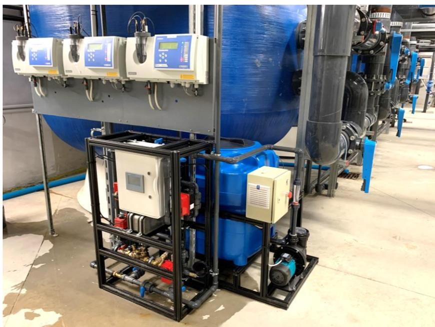
Le centre aquatique de Malbentre comporte 3 circuits chauffés (bassin sportif, bassin ludique et balnéo), chacun avec un groupe d'analyseurs pH/Chlore. Les douches massantes sont alimentées en eau depuis le circuit Balnéo. Le contre-lavage de filtre fait l'objet d'un système d'ultrafiltration qui permet de réduire la quantité d'eau rejetée.
