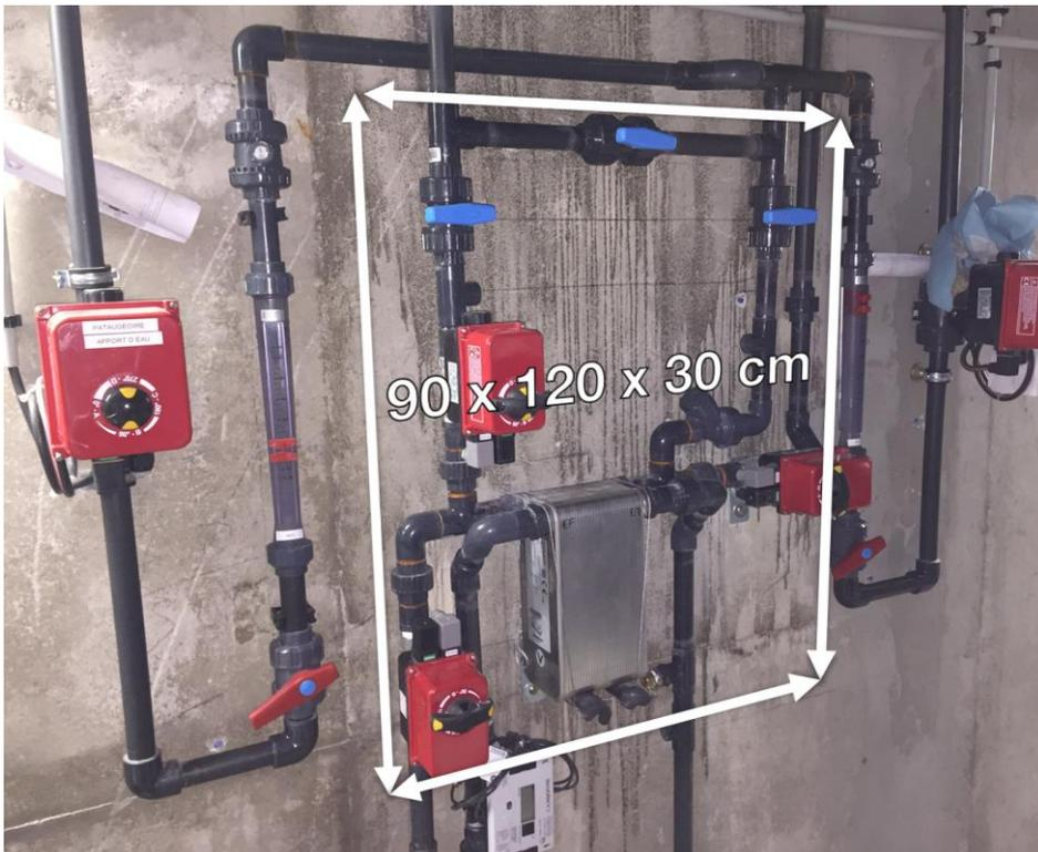
Ci à gauche : pour répondre à une contrainte de place, Obox P a été « reconstitué » sur le mur d'une course de la zone technique. Le tableau électrique d'Obox P est déporté 3 mètres plus loin.
